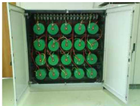
Рис. 3. Шкаф со смонтированной батареей ионисторов, емкостью 21 Ф
